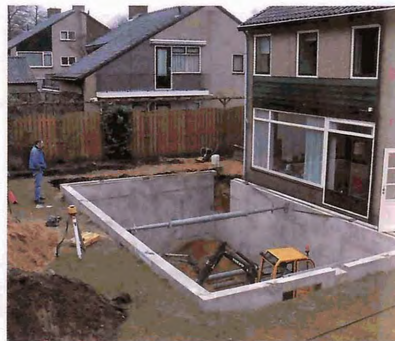
De overlast voor de omgeving blijft minimaal. Binnen een werkweek is de kelder geplaatst, de vloer gestort en de binnenkant afgewerkt.
