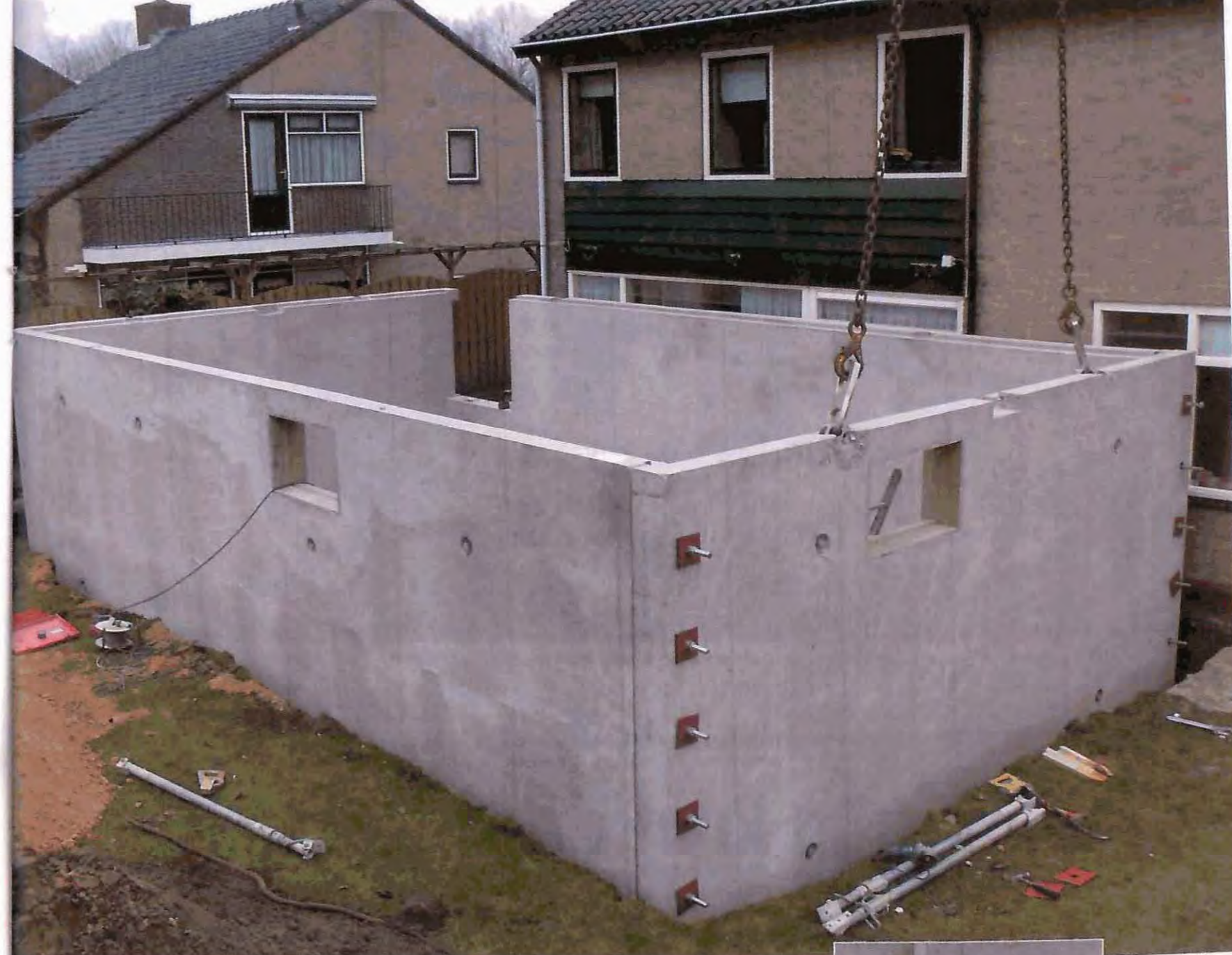
De geprefabriceerde kelderwanden worden over de woning heen gehesen en op maaiveldniveau gemonteerd.
