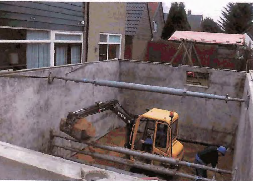
De grond binnen de kelderwanden wordt geleidelijk afgegraven.
