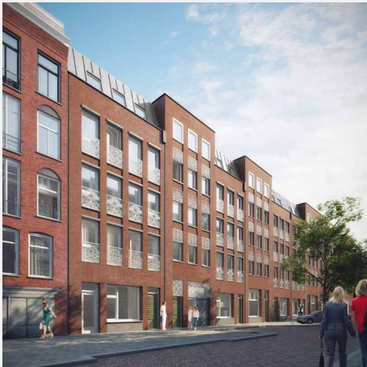
ANIMATIE VAN WOONBLOK 3 e OOSTERPARK-STRAAT IN AMSTERDAM. TRADITIONELE ARCHITECTUUR MET EIGENTIJDSE ACCENTEN. IN DE HEKWERKEN VAN DE BALKONS ZIJN OUDHOLLANDSE KANTPATRONEN IN GEVLOCHTEN STAALDRAAD VERWERKT, NAAR EEN ONTWERP VAN DE MAKERS VAN.
