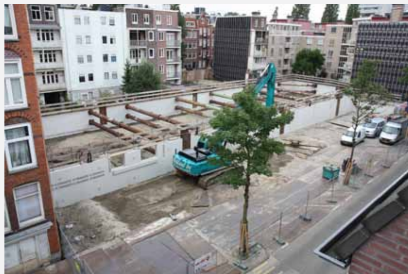
HET AFZINKEN VAN DE KELDER. IN TWEE WEKEN TIJD IS DE KELDER VAN 60,5 X 23 METER (L-VORM) AFGEZONKEN.
